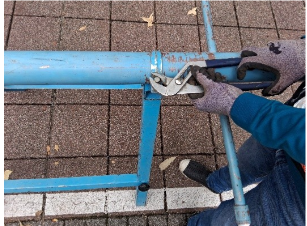
說明 取水架及取水帶架設中
